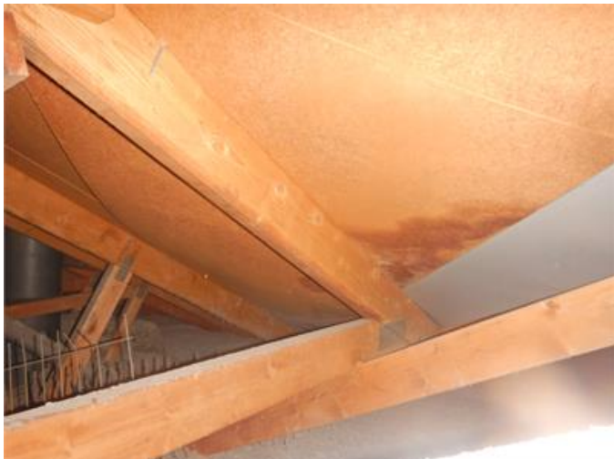
Undersida rännal på vinden
