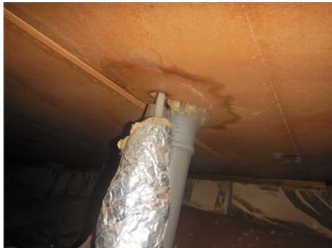
Genomföring från från kryppgrund
