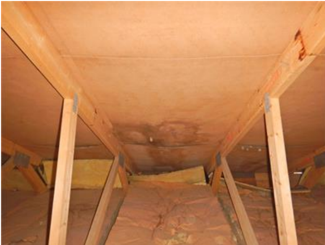
Missfärgning underlagstak
