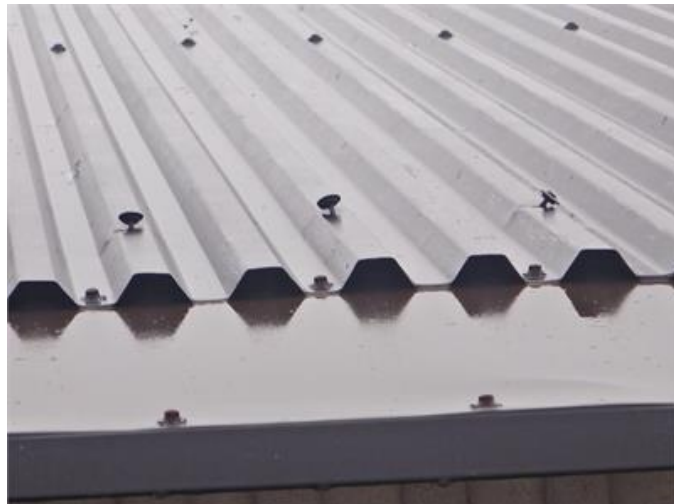
Lösa spikar i plåttaket och otätheter omkring spikhål.
