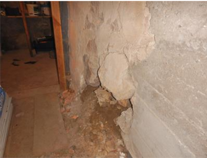
Grundmur i källaren
