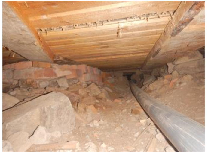
Undersida bjälklag från lucka
