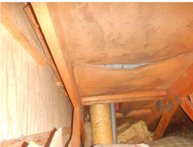
Takskivor har släppt från infästning på vinden.
