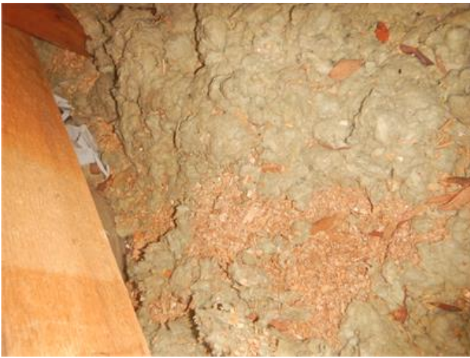
Blandning av isoleringsmaterial på vinden
