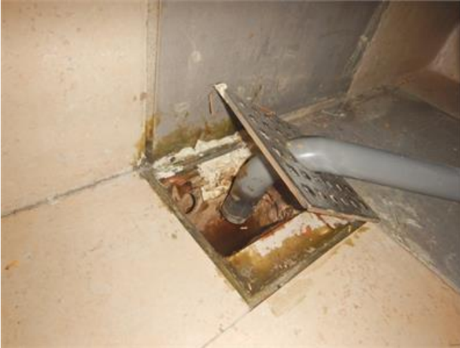
Äldre golvbrunn placerad nära vägg i badrum
